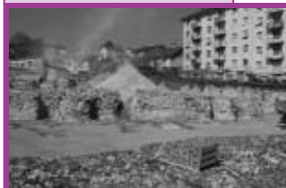
Concassage rue Paul Bert sur ancien emplacement boisé.
